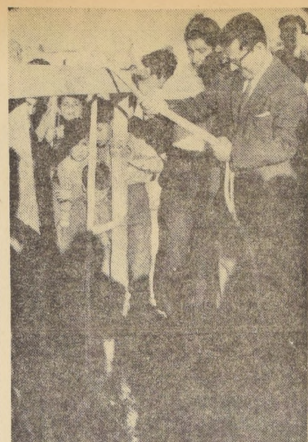
COLOCACION DE PRIMERA PIEDRA DEL CENTRO COMUNITARIO... El jefe de Equipamiento de la Consejería Nacional de Promoción Popular, Benjamin Maluenda, procede a colocar la primera piedra en el lugar en que se construirá un Centro Comunitario y una Policlínica en el sector de Las Achupallas, de Viña del Mar.
