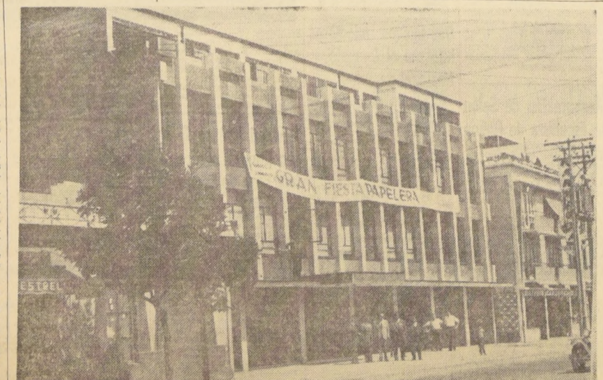
LA MEJOR SEDE SINDICAL DEL PAIS. — Frontis del edificio que el Sindicato de Papeleros de Puente Alto inaugura hoy a mediodía. Tiene cuatro pisos y ocupa 1.400 metros de superficie edificada. Ha sido financiado con la inversión de parte de la participación de utilidades que percibe el Sindicato. La Compañía anticipó los fondos invertidos, de los cuales más del 50% han sido ya cancelados por el Sindicato.
