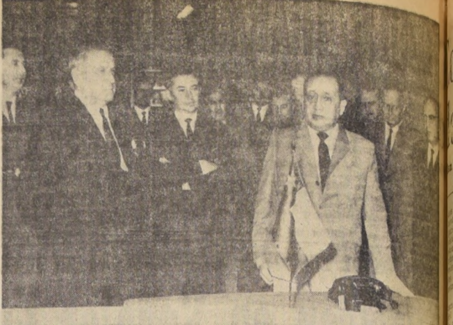
En la tarde de ayer fue inaugurada la nueva central telefónica automática que lleva el nombre de Planta Principal III y que permitirá la instalación de nuevos aparatos telefónicos en el sector céntrico de Santiago. EN EL GRABADO, el Ministro del Interior, Bernardo Leighton; el Subsecretario de la misma Cartera, Juan Hamilton, al centro; el Gerente General de la Compañía de Teléfonos, Benjamin Holmes, a la izquierda, durante la ceremonia inaugural.
