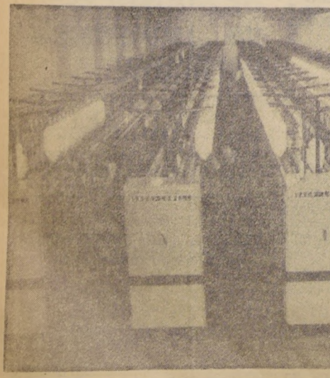
Grupo de las modernas máquinas Saco-Lowell, cuya línea ha sido instalada en la modernísima Hilandería Sedylán que se inauguró ayer, contigua a la misma planta manufacturera.
