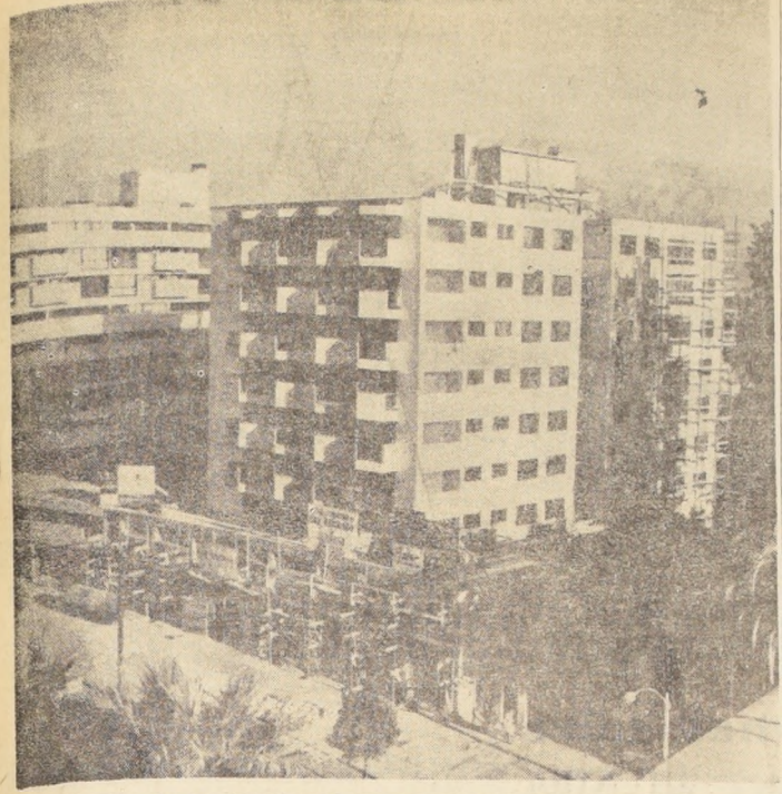
Aspecto del edificio de departamentos y locales comerciales ubicado en Avenida Providencia N° 2547. Consta de doce locales comerciales, 28 departamentos y una sala de cine con cuatrocientas treinta y una aposentaduras. Arquitecto: Victor Emanuel B.
