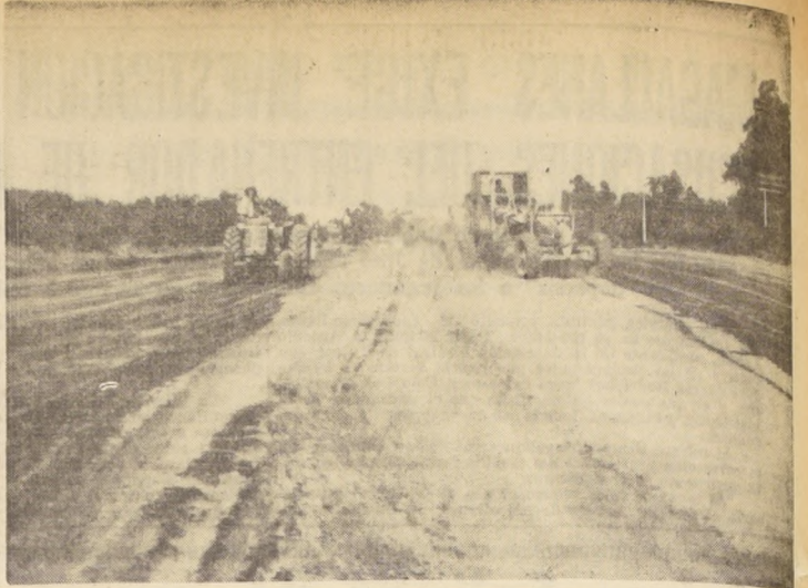
CON INTENSIDAD PROSIGUEN los trabajos de construcción del autódromo "Las Vizcachas". La pista, con cinco espectaculares curvas, ya está terminada en la etapa de movimientos de tierra y en el curso de la próxima semana se inicia la colocación del asfalto. Se cumplirá el trazo de entrega prometido: segunda quincena de febrero. En el grabado, una motoniveladora y un rodillo dan los últimos toques a una de las rectas.
