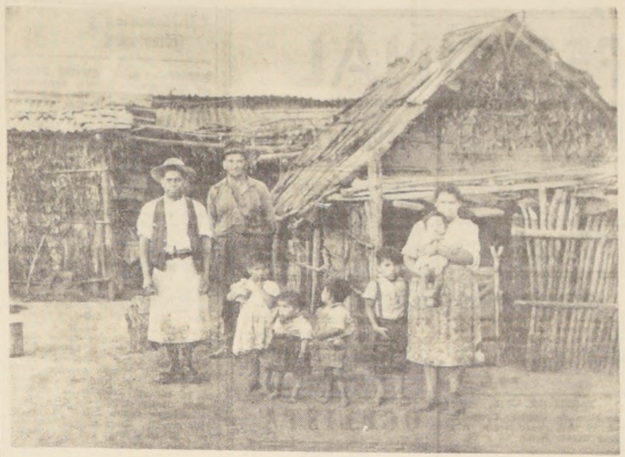
En verdaderas chozas viven los inquilinos del Fundo "El Arrayán", de Rancagua, sin los servicios sanitarios mínimos. Los trabajadores de la tierra y sus familias están amenazados de despidos por el propietario de este predio que pretende burlar la reforma agraria procediendo a parcelar el fundo y luego a rematarlo en lotes.
