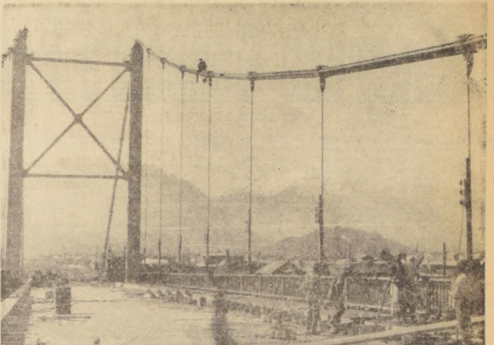
UNA DE LAS DOS OBRAS más importantes en su género, construida por la Dirección de Vialidad de la Dirección General de Obras Públicas en el país, y una de las más grandes de Sudamérica, es el puente colgante sobre el río Aisén que será inaugurado por el Presidente Eduardo Frei. El puente tiene una longitud de 210 metros y una calzada de 8 metros de ancho, para el tránsito de los peatones. Es de tipo colgante, con torres y vigas metálicas. La estructura metálica fue encargada a la firma Krupp, de Alemania, y demandó una inversión cercana a los 370.000 dólares, incluyendo el flete desde Hamburgo a puerto Chacabuco.
