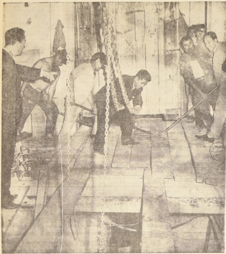
Intensa actividad provocó en la Cámara de Diputados la instalación de una cámara de refrigeración, que fue colocada en un subterráneo especialmente construido en el edificio de la Corporación. La máquina fue importada desde los Estados Unidos, y tiene por objeto mantener una temperatura adecuada en el hemiciclo de la Cámara, tanto en verano como en invierno. Esta máquina pesa 4 toneladas, y tiene
