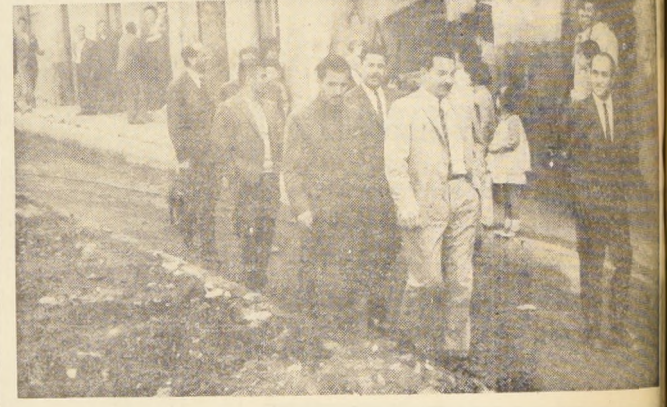
VALPARAISO.— ALCALDE RODRIGUEZ EN LOS CERROS.— El Alcalde Subrogante Juan Rodríguez se encuentra recorriendo activamente los cerros de Valparaíso, donde se realizan trabajos de pavimentación, comprobando la forma en que se
