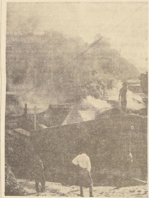
Una vista parcial del incendio que a mediodía de ayer destruyó un edificio donde funcionaban la Secretaría del Partido Comunista y varios locales comerciales, en Valparaíso.
