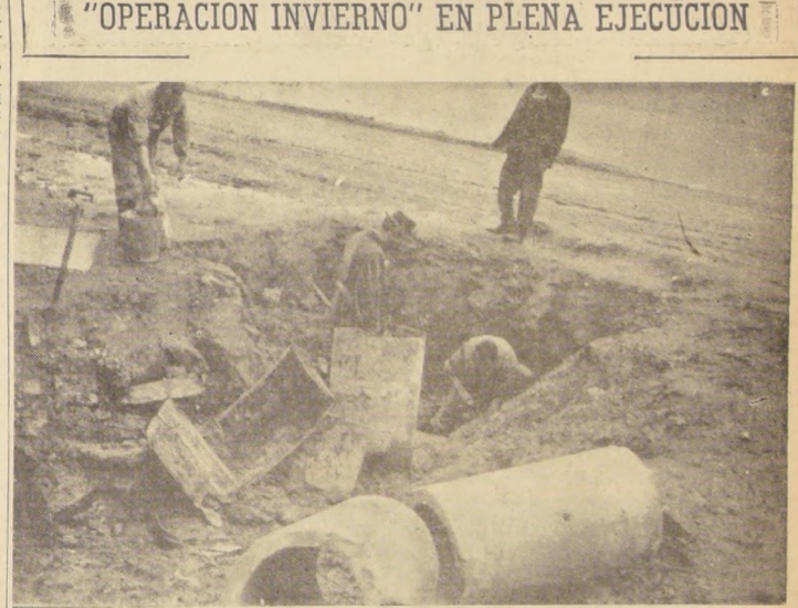
Con el aporte de mano de obra de los vecinos y los esfuerzos conjuntos del Estado y entidades particulares que facilitan maquinarias, materiales y herramientas, continúa en las provincias sureñas la "Operación Invierno", campaña destinada a prevenir los estragos que ocasionan las lluvias y su secuela, los temporales en los barrios populares. Actualmente, esta operación se está desarrollando en las provincias de Llanquihue, Osorno y Valdivia, zonas que experimentan los rigores del invierno. Más de cien hombres trabajan en cada zona con maquinarias fiscales y particulares, bajo la responsabilidad de Intendentes, delegados de Promoción Popular, jefes de servicios y representantes de organizaciones populares comunitarias. Durante esta semana, la campaña se extenderá al norte, hasta completar las 15 provincias incluidas en este trabajo de la comunidad con el Estado. EN EL GRABADO, un aspecto de los trabajos que realizan los pobladores de Valdivia, contando con la asistencia técnica y maquinarias necesarias. Los vecinos han realizado trabajos de enripiado, rellenos y pavimentación.
