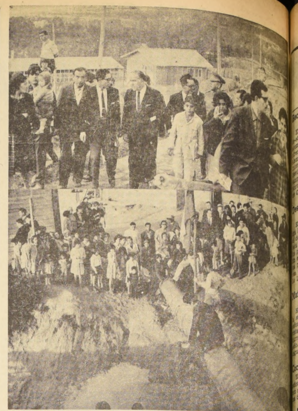
VALPARAÍSO.— TRABAJO DE MUJERES PORTENAS.— Una labor comunitaria ejemplar y de grandes proporciones está realizando en este puerto un grupo de 62 mujeres del cerro San Roque, las que inaugurarán con asistencia de las autoridades un servicio de agua potable que unirá San Roque con Rocuant Alto. En el grabado, arriba, el Intendente, Enrique Vicente, el Alcalde, Juan Rodríguez, el coronel Alberto Aranda y otros personeros que asistieron al acto realizado en Rocuant Alto, quedaron impresionados por la tesonera obra de este grupo de 62 mujeres porteñas, que usando paños y chuzos han realizado excavaciones de más de 380 metros de extensión en el plazo indicado. De este modo, ellas elevan a 12 el número de poblaciones que disponen ya de agua potable en el sector, uno de los más populosos de la zona.
