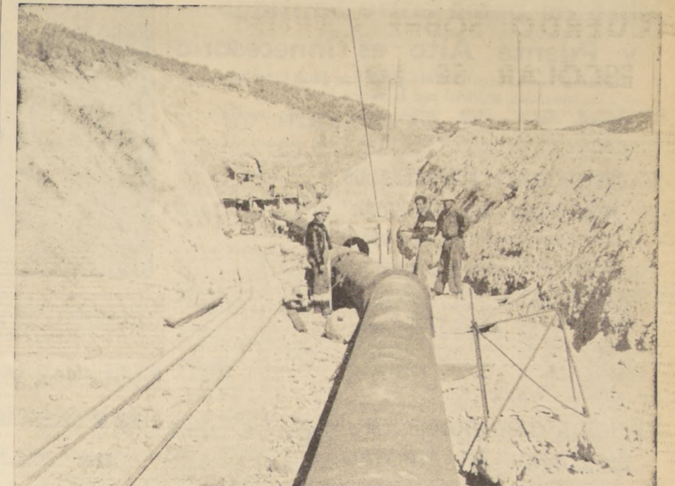
Una gruesa tubería, conduce el agua desde el túnel que la Dirección de Riego, construyó en el río Lauca, hasta las turbinas de la Central de Chapiquiña. El tendido de los tubos, que se aprecian en el grabado fue una dura faena, que hubo que efectuar a alturas que fluctuaron entre los tres y cuatro mil metros. Esta tubería, que llevará el agua a presión, tiene una longitud de 4.200 metros y un desnivel de un kilómetro, que permitirá generar abundante energía eléctrica para Arica, Iquique y lugares intermedios.
