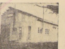
Esta bodega de ECA corresponde a la zona de la Villa La Tapera.
