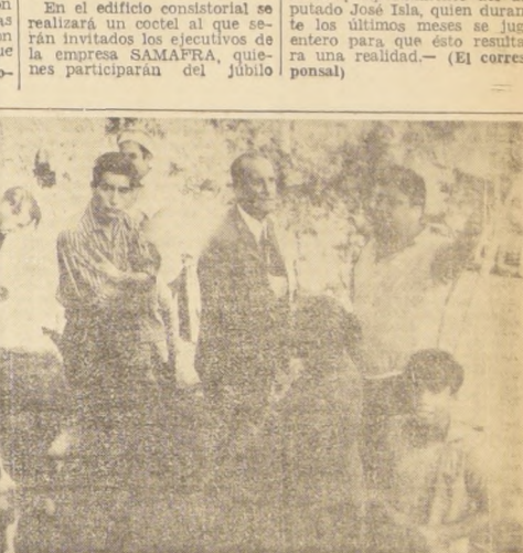
VALPARAISO.— DIPUTADO MONTEDÓNICO SE INFORMA DE TRABAJOS.— El diputado Juan Montedónico se encuentra visitando las poblaciones para informarse de diversas demandas de pobladores y trabajos que se realizan. En el grabado, el diputado porteno aparece en la población "Vicuña Mackenna" de este puerto, donde se realizan trabajos de limpieza de caminos para que pueda abrirse paso la pala mecánica que allí se encuentra en funciones.
