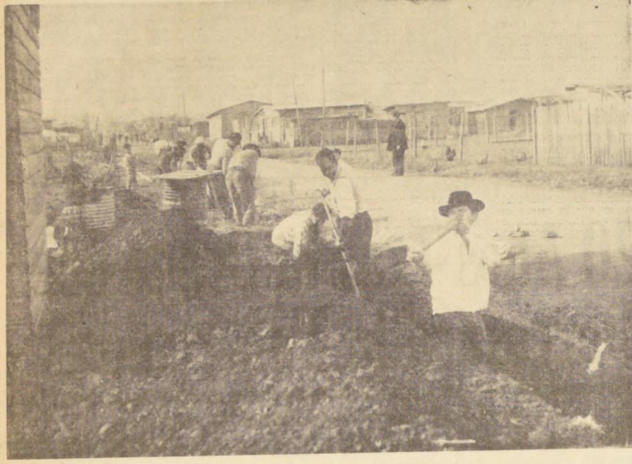
SE INICIARON los trabajos de instalación de agua potable en el sector Peñalolén, con el carácter de urgencia, a pedido del Presidente de la República, y con el aporte de mano de obra de los vecinos de las poblaciones "El Progreso", "San Judas Tadeo", "Peñalolén" y "San Roque". Gracias a las gestiones ante los Ministerios respectivos de
