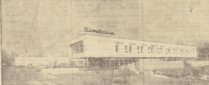
Vista panorámica del edificio de Administración de SINDELEN, en cuyos bajos está el Hall de Exhibición de productos de esta industria.
