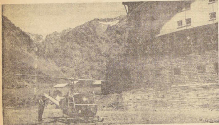
Durante todo el verano de 1966, se estuvo trabajando en Portillo, para ampliar sus instalaciones y construir otra. Un verdadero Helipuerto hay ahora tras el Hotel. EN EL GRABADO, vemos un helicóptero realizando trabajos.
