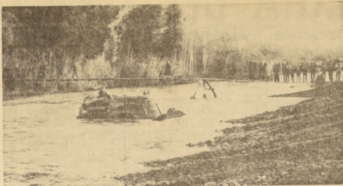
En forma oportuna se ejecutaron los trabajos en las riberas del Río Claro para estar las inundaciones a poblados campesinos de Rengo por iniciativa del Gobernador, Guillermo Zapata. En el grabado un bulldozer de 18 toneladas desbanca el Río Claro acarreando tierra y ripto a su ribera, mientras es observado por las autoridades locales.
