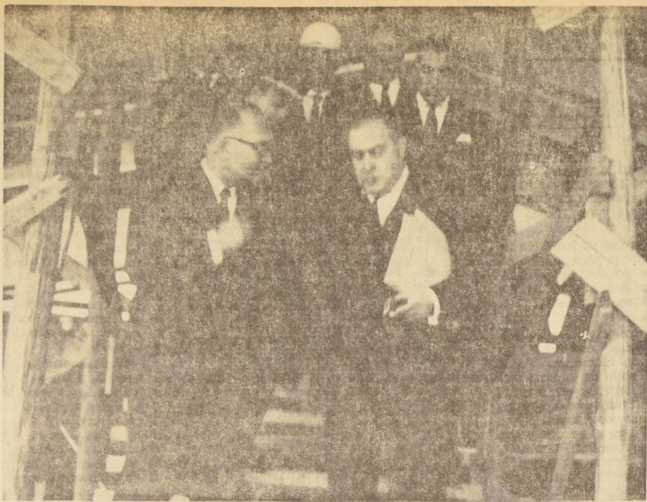
Una detenida visita para comprobar el estado de los trabajos de construcción del Aeródromo Internacional de Pudahuel efectuaron en el día de ayer los Ministros de Economía, Domingo Santa María, Obras Públicas, Edmundo Pérez Zujovic y de Defensa Nacional, Juan de Dios Carmona. Durante la inspección de las obras adoptaron de inmediato resoluciones para asegurar la entrega y funcionamiento del puerto aéreo el 30 de noviembre próximo. En el grabado: los Secretarios de Estado, altos jefes de la Fuerza Aérea y de los Ministerios a su cargo, durante la visita.
