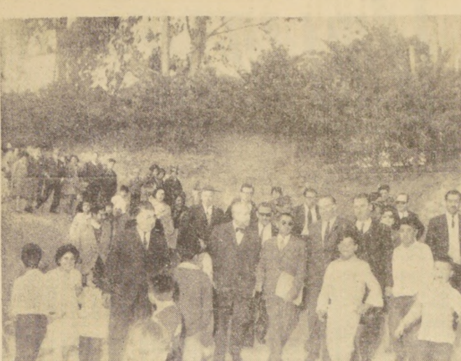
El Alcalde de Valparaíso, Adolfo Airola, en compañía del Intendente, don Enrique Vicente, realizó un recorrido por diversos cerros donde se efectuarán obras de pavimentación y desagüe.—EN EL GRABADO, vemos a las autoridades con pobladores del cerro Pajonal.
