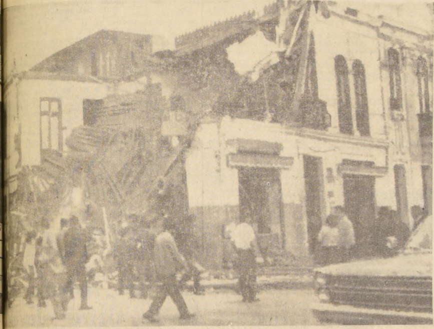
Un edificio dañado a consecuencias del fuerte sismo que sacudió al país el 17, da una idea de la magnitud del terremoto que dejara un saldo trágico, que la cifra oficial calcula en 110 muertos y más de tres mil heridos y daños cuantiosos. (RADIOFOTO UPL)
