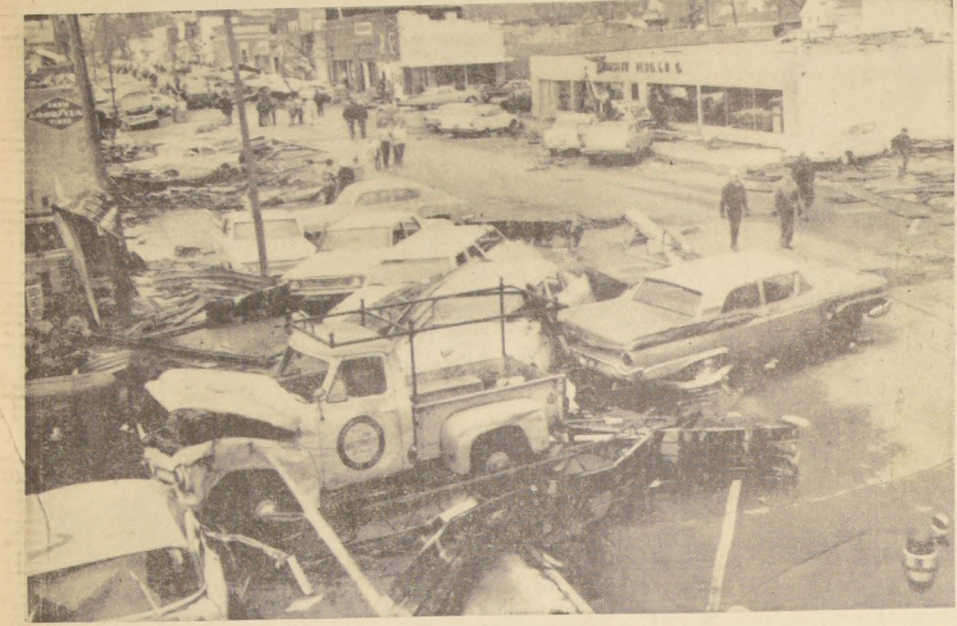
Belmond, (EE. UU.): Vehículos y edificios quedaron destruidos en Belmond, Estado de Iowa, después del tornado que azotó la ciudad, matando 6 personas y causando daños estimados en varios millones de dólares. (Telefoto UPI)
