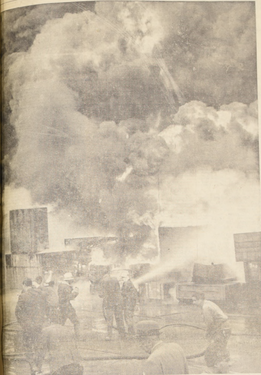
El fuego que causó en el puerto de Valparaíso el incendio que se declaró alrededor de las 10.30 horas de ayer en el sitio 3 de la Aduana. Las llamaradas se elevaron a gran altura y espesas columnas de humo hicieron temer la repetición de una tragedia como la registrada al iniciarse el primer día del año 1953. Felizmente, el fuego fue apagado poco después del mediodía. En el grabado, bomberos y obreros portuarios desarrollan febril actividad combatiendo el fuego, que dejó subidas pérdidas.
