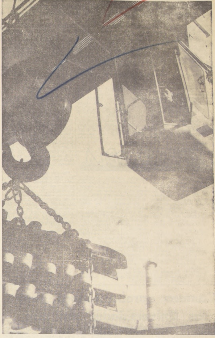
Una gigantesca grúa transversal carga los lingotes de cobre electrolítico listos para ser embarcados con destino al exterior. Una vez que la Refinería de Ventanas esté en plena producción, podrá refinar todo el cobre que produce actualmente la pequeña y mediana minería nacional y parte de la producción de cobre blister del mineral de El Teniente.
