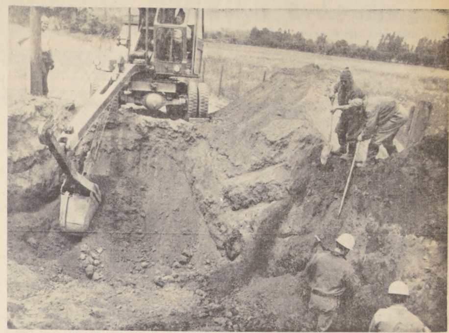
Esta tarde se normalizará el abastecimiento de agua potable en el sector comprendido entre La Higuera, Quilín, José Pedro Alessandri, Camino Lo Agrícola, Vicuña Mackenna, Ochagavía y Camino Departamental. Se debió reemplazar una cañería matriz de 800 milímetros que se encontraba a más de 8 metros bajo tierra. La empresa de Agua Potable se disculpa ante el público afectado y agradece la cooperación brindada por Carabineros, Bomberos y Municipalidades.
