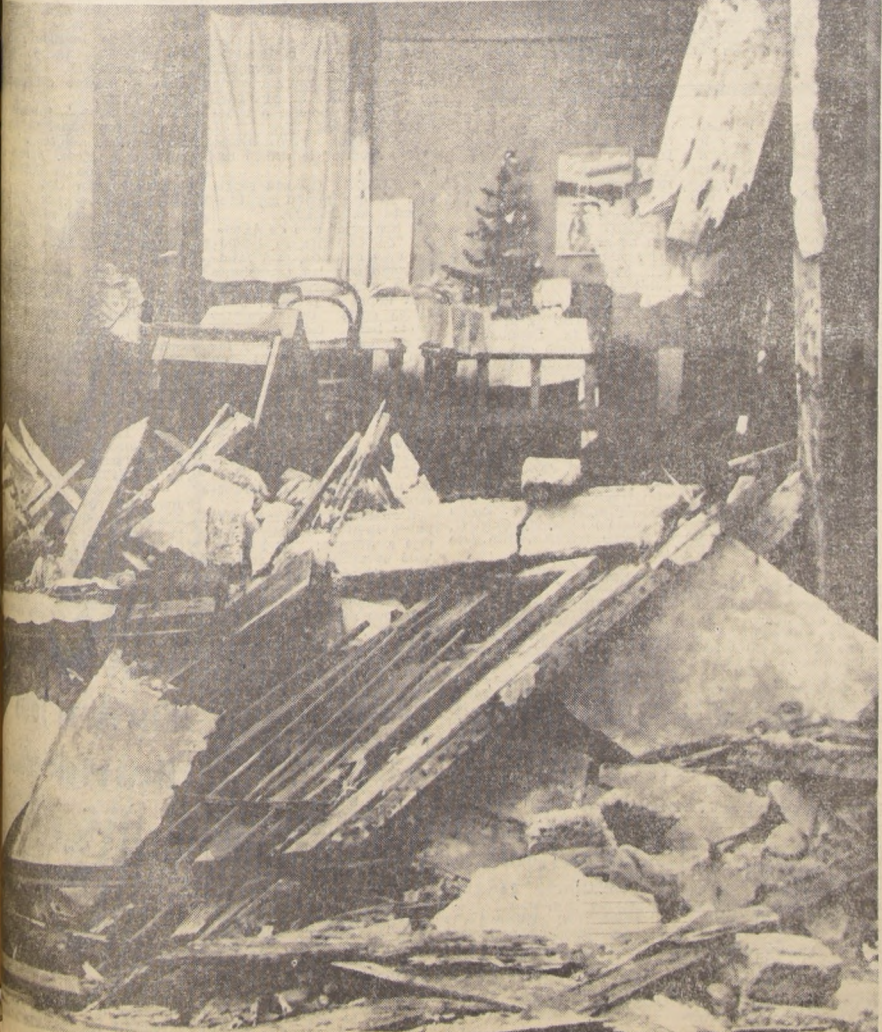
Las casas de Taltal quedaron con sus interiores destruidos, como ésta que muestra el grado, aunque casi todas las fachadas permanecieron intactas.
