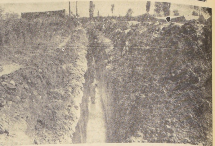
LAS BARRANCAS.— En forma acelerada se trabaja en el pueblo antiguo de Las Barrancas y en 10 poblaciones en la instalación de la matriz del alcantarillado, con lo que esta comuna podrá contar con este servicio que era indispensable para mejorar sus condiciones sanitarias. Con moderna maquinaria se hacen las zanjas de unos 10 metros de profundidad, colocándose en ella la gran tubería de la red matriz. EN EL GRABADO, una de las zanjas, con la tubería ya colocada en su fondo. (Barraona, corresponsal).
