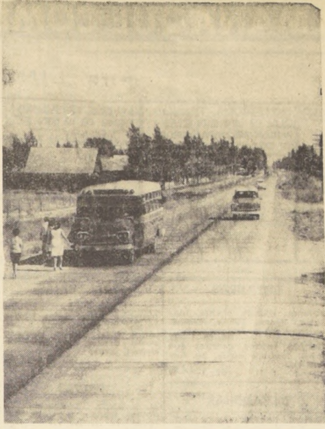
Nuevos aportes de organismos internacionales están posibilitando la comunicación entre los países latinoamericanos. La Carretera Panamericana, cinta de cemento que ya recorre las principales capitales, se alarga y crece hacia el sur. De Castro a Quellón, en Chile, se ha materializado el sueño de una ruta segura que simboliza la unión americana y su futura integración total.
