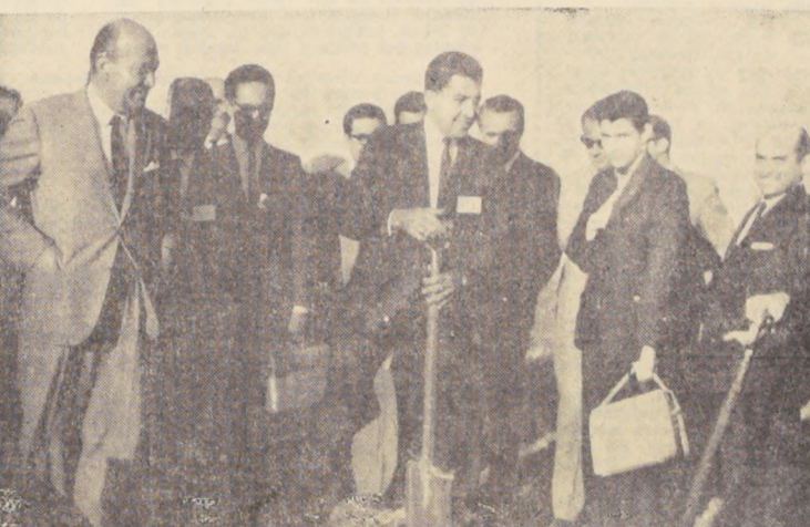
El Ministro de Economía, Fomento y Reconstrucción, Domingo Santa María, inauguró oficialmente las faenas de la construcción de la planta de Máquinas de Coser Singer Chilena S. A. junto con ejecutivos de la Singer Sewing Machine Company.
