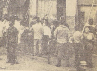
Un cortocircuito provocó un incendio que afectó seriamente cuatro locales...
