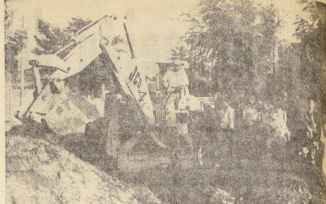
CONCHALI. — Con rapidez se están ejecutando los trabajos de instalación de alcantarillado en cinco poblaciones del sector norte de esta comuna, que comprende a El Carmen, El Mansanal, Independencia y Anexa Independencia. Esta obra fue impulsada por los dirigentes Alvarez, Medina y otros de la Unión de Fobladores. — EN EL GRABADO se puede apreciar un aspecto de los trabajos que se están realizando y a un grupo de vecinos que observan las labores.
