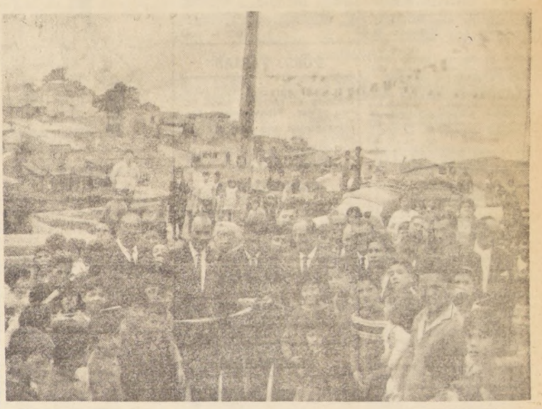
Con asistencia del Alcalde de Valparaíso, Juan Rodríguez, el senador Benjamin Prado, el diputado Juan Montedónico, y otras autoridades, fueron inaugurados en el cerro Mesilla de este puerto los trabajos de pavimentación que se efectuarán en calle Paulino Alfonso. En el grabado, el Alcalde de esta ciudad corta la cinta dando por inaugurada la obra, mientras lo rodean los felices pobladores del sector.
