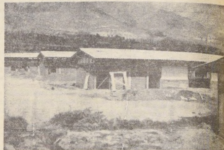
Esta es la Escuela N° 121 República de Chipre, que la Sociedad Constructora de Establecimientos Educativos está ya terminando junto a la villa Fundo La Reina.
