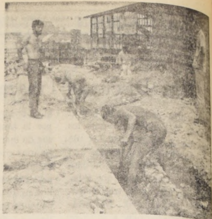
En el curso de esta semana llegarán a Santiago los estudiantes universitarios que construyen una escuela en Lima, conjuntamente con 8 obreros especializados y arquitectos chilenos que permanecerán una semana más, para ultimar los detalles de la construcción. La escuela tiene capacidad para 720 niños. Consta de 8 aulas, biblioteca, casa para el cuidador, servicios higiénicos, 2 multitalleres, cocina y cancha deportiva. Posteriormente, viajarán a la capital peruana a la inauguración oficial el Ministro de Educación, Juan Gómez Millas, y presidente de la Sociedad Constructora de Establecimientos Educativos, Gastón Saint Jean. El Ministro de Educación del Perú ofreció a los jóvenes transportarlos en un avión especial hasta el Cuzco, para que visiten las ruinas de Machu Picchu, antes de su partida a nuestro país.
