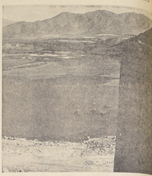
OVALLE.— El embalse de "La Paloma" construido dentro de la Alianza para el Progreso quedará en funciones a fines del presente año regando 2.000 nuevas hectáreas de terrenos y mejorando el riego de otras 57.000 que actualmente están expuestas a la sequía. EN EL GRABADO se puede apreciar parte del tranque de La Paloma que tiene una superficie de 20 kilómetros cuadrados y que dejará bajo sus aguas al pueblo de El Palqui que será reconstruido por la CORVI en terrenos ubicados sobre el nivel de sus aguas.
