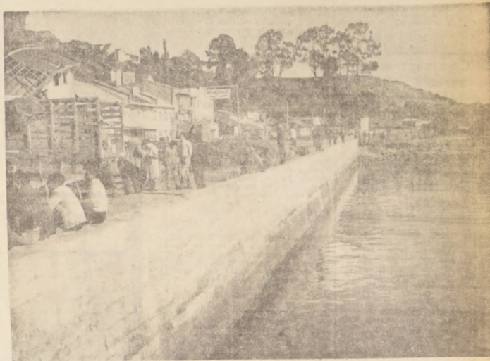
CASTRO.— Las numerosas obras públicas, escuelas, viviendas y el fomento a las actividades productoras de la región, son una clara demostración de la acción del Gobierno del Presidente Frei en favor de la provincia de Chiloé y las necesidades de sus habitantes. En el grabado se puede apreciar un muro de contención que forma parte de la reconstrucción y habilitación del puerto de Castro.
