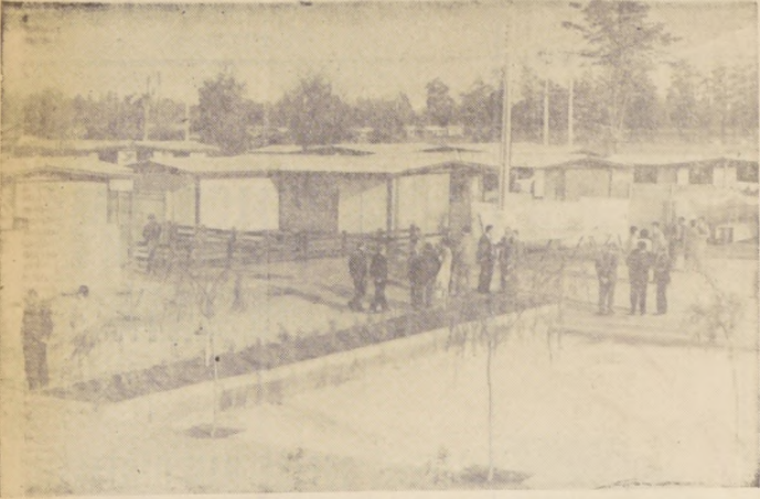
Seiscientos casas de estructura metálica inauguró en Rapel la ENDESA, viviendas destinadas a sus operarios que de esta forma se convirtieron en nuevos propietarios. Dicha empresa, a los favorecidos, les brindó asistencia técnica y económica. La obra en general fue dirigida por la oficina del Plan Habitacional de la ENDESA. Cada vivienda tiene 66,50 metros cuadrados de superficie y en sus dependencias se han instalado todos los servicios indispensables. El grabado muestra una vista parcial de este grupo habitacional.
