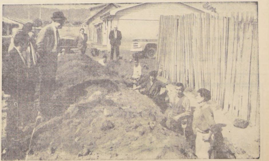
Un ejemplo de lo que puede la voluntad, están dando los pobladores del sur que, restando horas al descanso trabajan en dotar de agua potable a sus hogares. Esta cruzada se extenderá por todo el territorio nacional. En el grabado, el Ministro Pérez Zuloaga inspecciona las labores en la Población Anita Hurlado, de Coronel.
