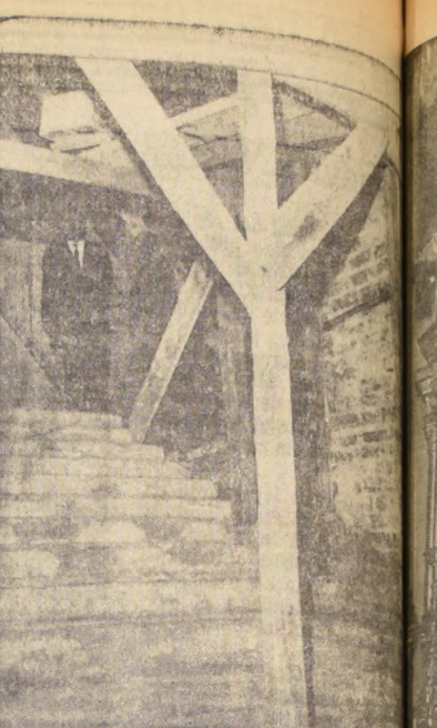
EL PLAN DE restauración del Palacio de la Moneda, que se inició hace algunos días, incluye la modernización de algunas dependencias y revestimiento de balcones. La escala de mármol que conduce al binete Presidencial tenía fallas, por lo que el BADO muestra un aspecto de los trabajos que ejecutan, con celeridad, para renovar la escala del Palacio de Gobierno.
