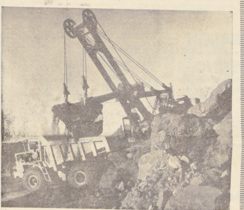
La máquina va desplazando al hombre en todos los campos. Miles de brazos, y en muchos casos el cerebro, son reemplazados por gigantes máquinas. Fábricas que empleaban a miles de hombres cuentan ahora con solamente unos pocos y varias máquinas...
