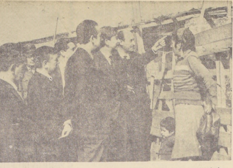
Reemplazando las ruinas del sismo de 1965, la acción del Gobierno por medio de la "Operación Techo" ha entregado habitaciones confortables a los que en aquella oportunidad resultaron damnificados...
