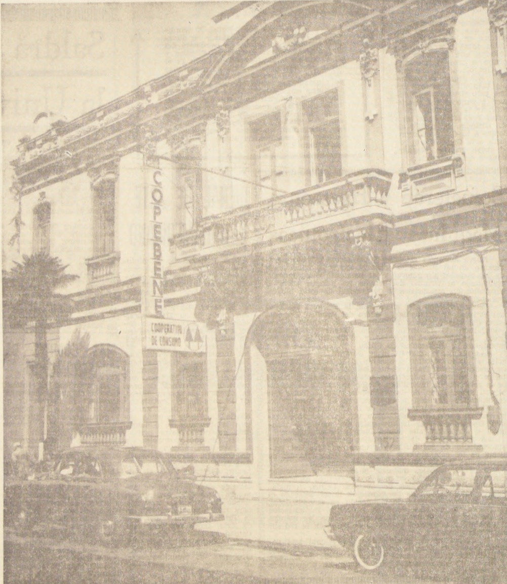
Frontis del edificio central de COPEBENE en la calle Santa Rosa N° 157.
