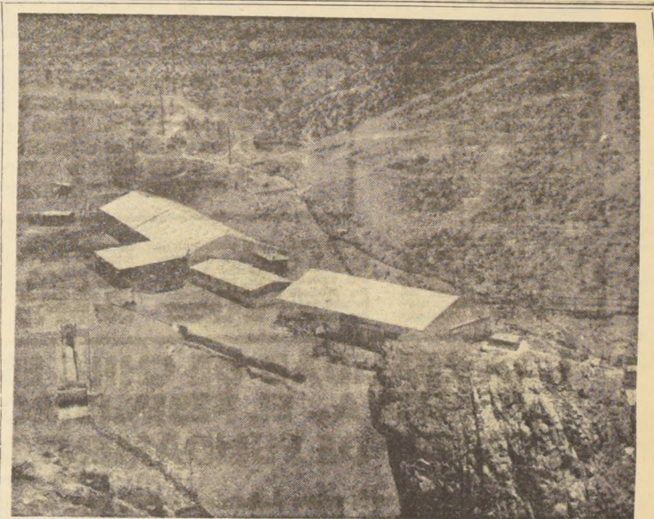
CENTRAL DE CHAPIQUINA.— En 1966 se ha cumplido el objetivo de dar decisivo impulso a la capitalización del país y a la expansión de la capacidad productiva.
