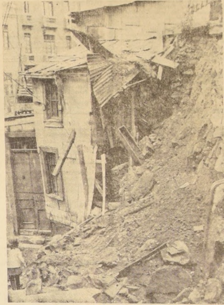
OTRO DERRUMBE PARTIO UNA CASA - La mitad de una casa quedó totalmente destruida, salvándose milagrosamente la otra mitad, al producirse en la mañana de ayer un derrumbe en la subida del Cerro Artillería, al llegar a Carampangue. Aunque ayer no llovió, el reblandecimiento de las paredes del cerro, por efecto del agua de los días anteriores, hizo ceder la estabilidad de un muro de contención, cayendo sobre la casa. Afortunadamente no hubo desgracias personales.
