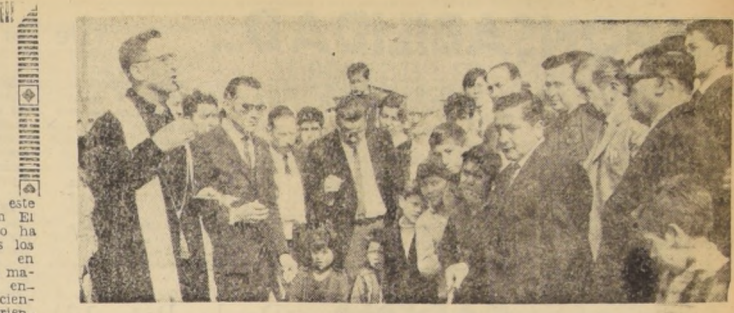
Ayer en la mañana se efectuó la bendición de las instalaciones de agua potable, red central y arranques domiciliarios en la Población Angel Burgueño, ubicada en La Cisterna. Esta obra fue realizada con el esfuerzo mancomunado de los pobladores, que constituyen 184 familias; del Ministerio de Obras Públicas, de la Municipalidad y de la Promoción Popular.
