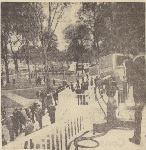
PARIS.— El Hipódromo de Longchamp (cerca de París) es sin duda uno de los primeros en que se haya instalado un sistema completo de televisión en colores. Este equipo incluye, entre otros aparatos, dos cámaras profesionales Philips, tío Plumbicón, y cerca de veinte receptores.
