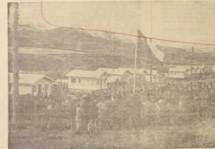
Viviendas en la zona austral.
