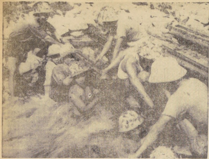
Una de las razones de la interminable guerra del Vietnam se puede apreciar en esta fotografía, de fuente comunista, en la cual una cuadrilla de trabajadores repara, con agua a la cintura, un puente recién bombardeado. (Foto UPI).
