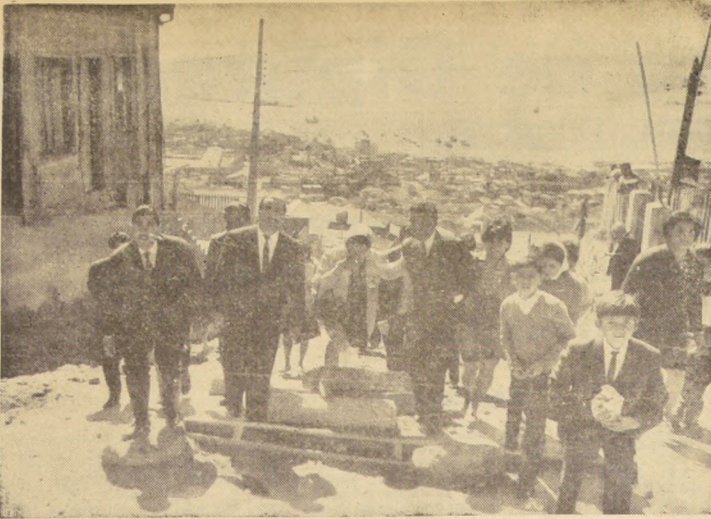
VALPARAISO - ALCALDE VISITA OBRAS DEL CERRO SAN JUAN DE DIOS. - El Alcalde Juan Rodríguez visitó las obras de pavimentación que se efectúan en la calle Agua Potable del Cerro San Juan de Dios...
