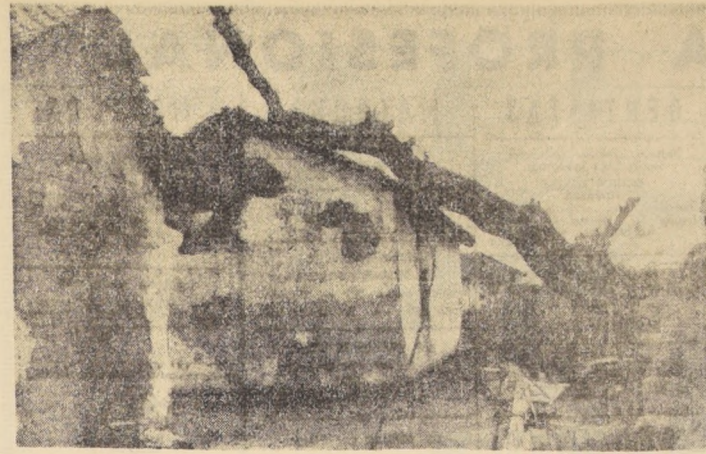
LAS BARRANCAS.— Estas son las casas en que viven los trabajadores agrícolas del fundo Lo Prado Abajo. Están en completo abandono, como sus moradores. Como para confirmarlo, un viejo árbol aparece derrumbado sobre la misera techumbre de una de las dos viviendas. (Fernando Baraona, corresponsal).
