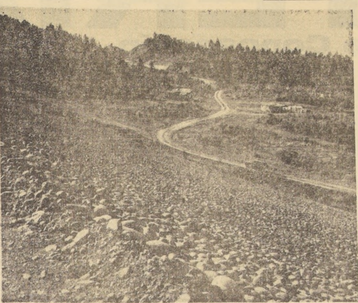
PARRAL.— El muro de tierra, de 80 metros de altura, del embalse Digua...
