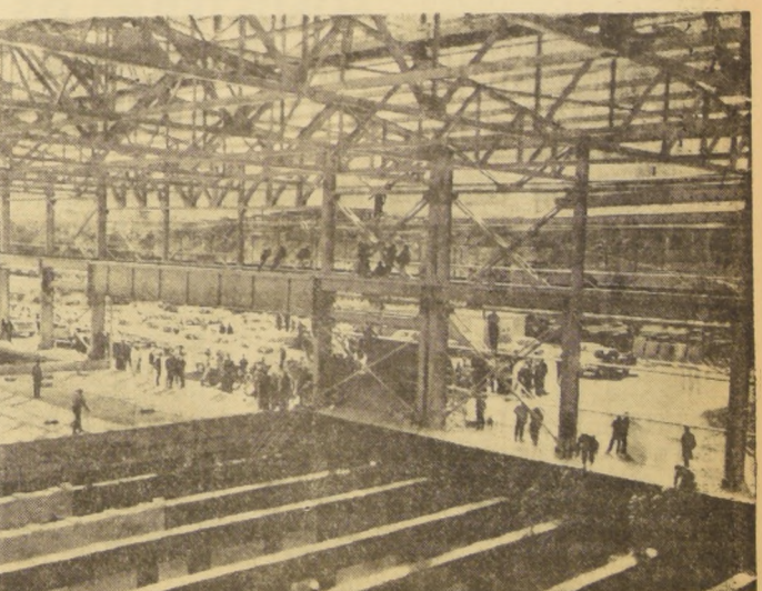
Las instalaciones de la Refinería de Chuquicamata fueron íntegramente inspeccionadas por la comitiva que encabezó el Presidente Frei, en su reciente visita a esa zona. Las posibilidades económicas que se le abren a Chile con la puesta en marcha de la nueva planta "La Exótica", son amplias y promisorias. Así lo ha entendido toda la ciudadanía.
